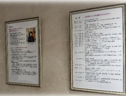
取付工事を行い設置された額縁
